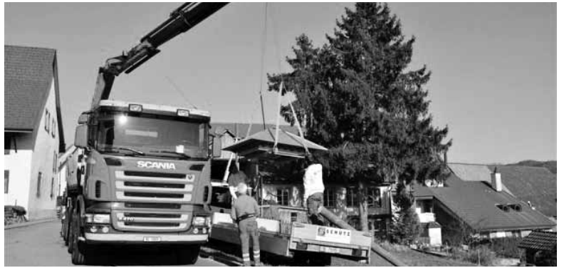
Die Stange und das Schwalbenhaus werden in Anwil montiert.
