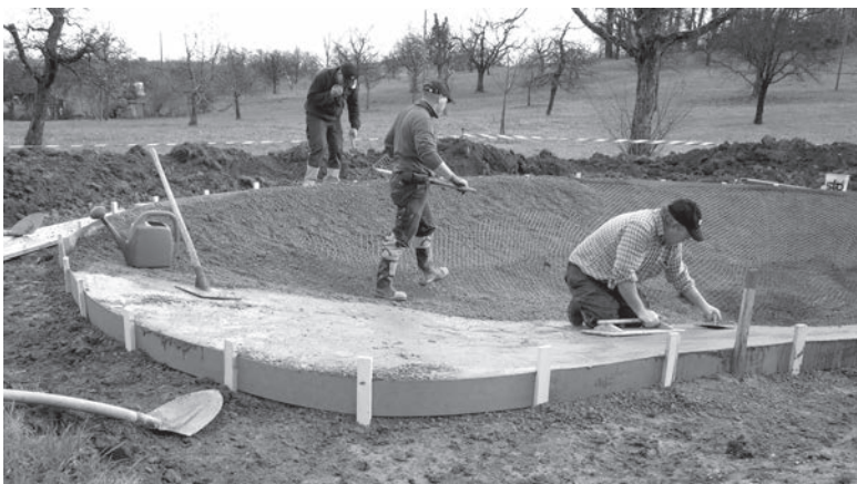
Bau des neuen Teiches im Dez. 2014
