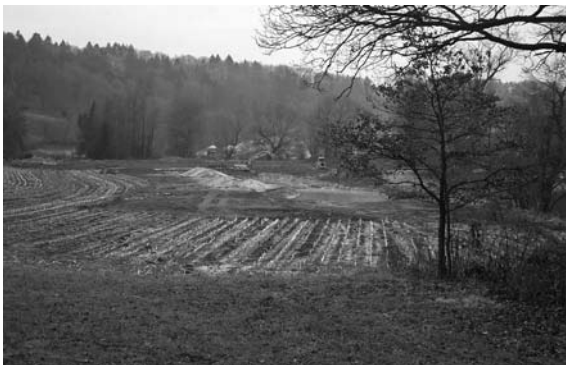
Baubeginn Dezember 2005. Foto Susanne Brèchet Schönthal
