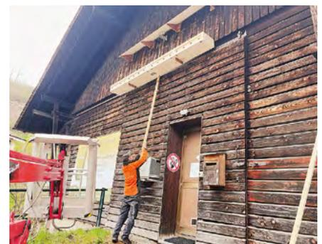
Es braucht nur eine kurze Hilfsintervention über den Torvorsprung, ansonsten kann das neue Mehrfach-Spyrenhaus am montierten Seilzug einfach von Hand aufgezogen, oben gesichert und wenn nötig wieder runtergelassen werden.
